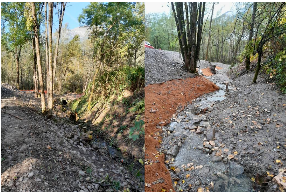
AVANT TRAVAUX (après débroussaillage)
